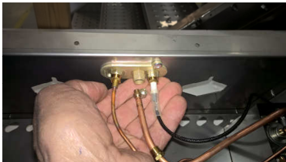
Kuva 5: Ota pilottipolttimen suutin käteesi
